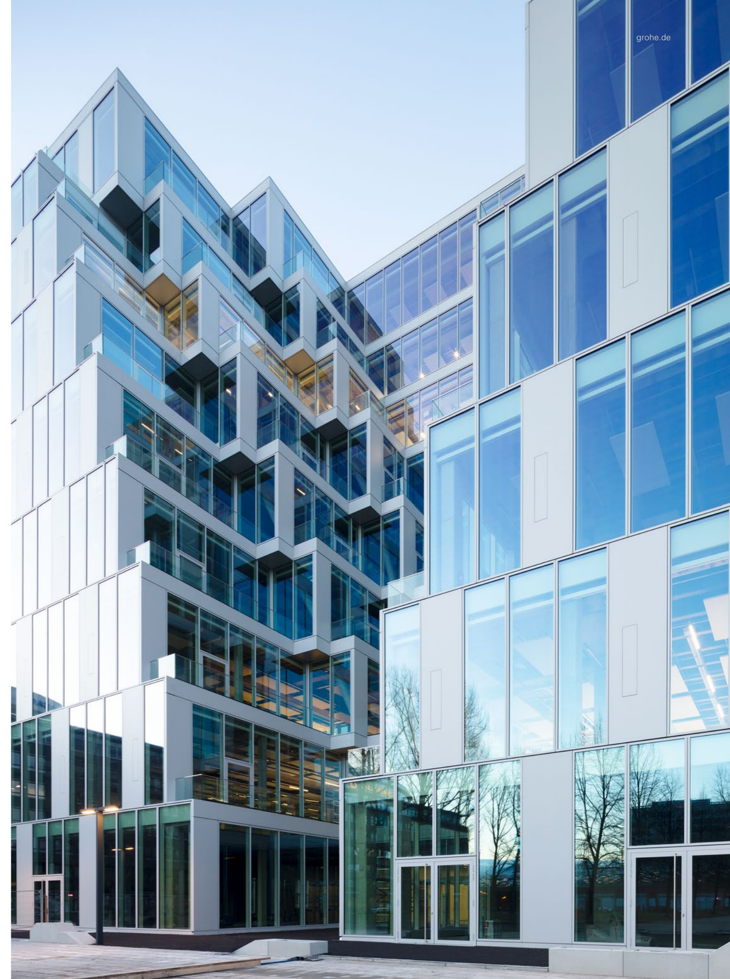
Im Bereich der Einschnitte wurde das Gebäudevolumen treppenartig gestaffelt. Das Bestandstragwerk wurde teilweise zurückgebaut, um auf jeder Etage eine Terrasse zu schaffen.
