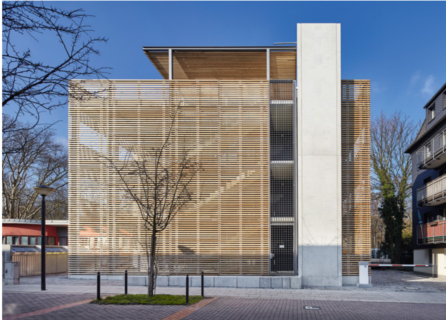
Das ehemalige Gemeindehaus wurde in einen attraktiven Lebensraum verwandelt. Eine transparente Lamellenstruktur umschließt die außen liegenden Erschließungselemente.
