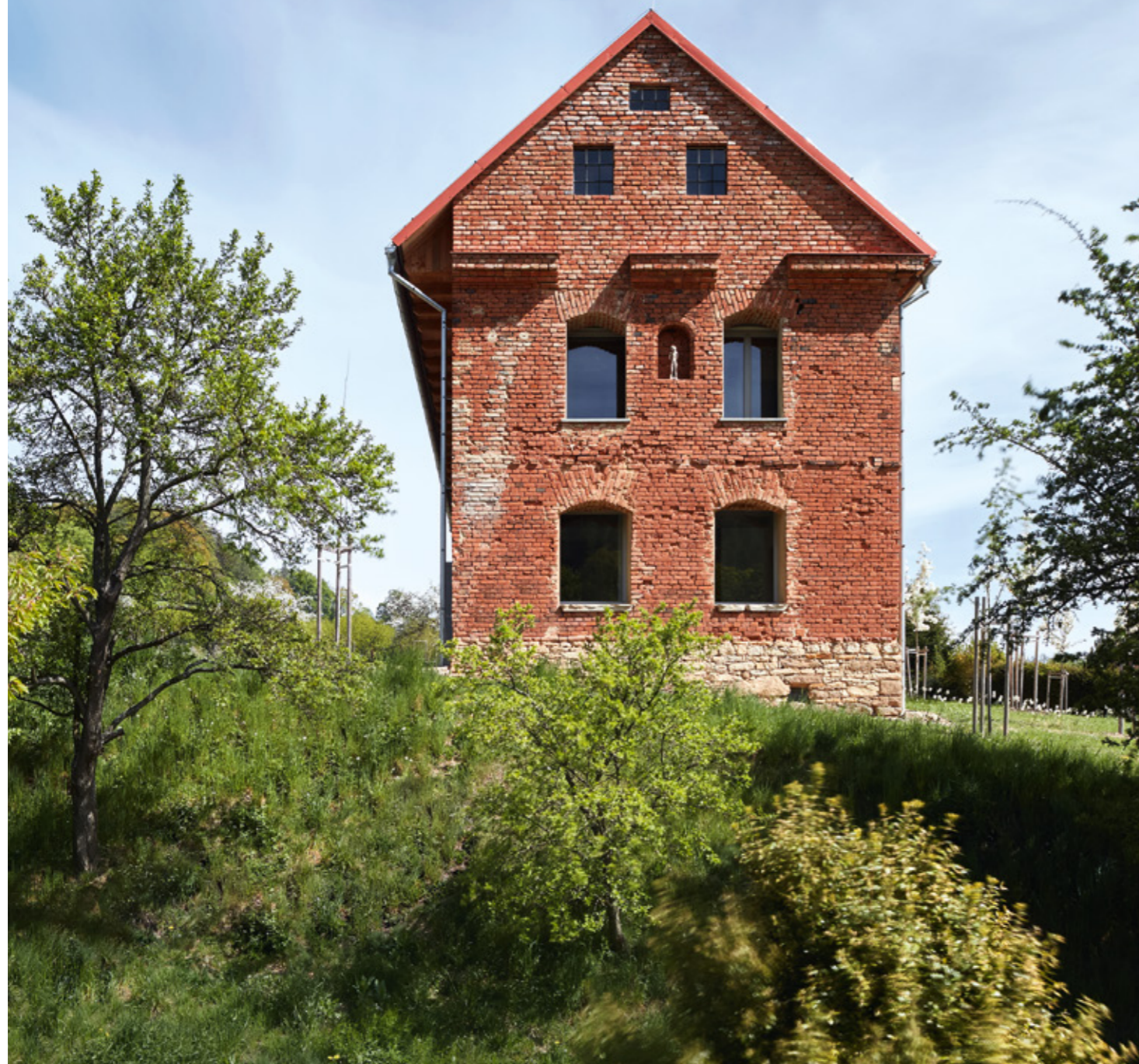
Außen alt, innen neu: Nahe dem tschechischen Brünn erweckten vier Architekten eine Ruine zu neuem Leben.
