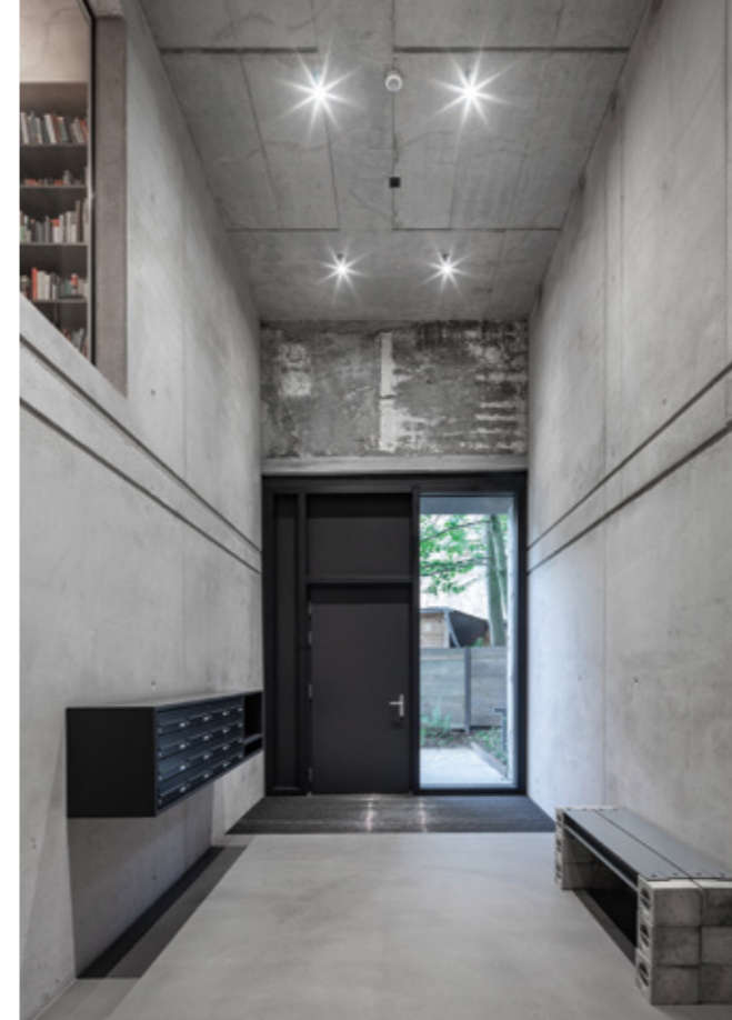
Im Eingangsbereich des umgebauten Bunkers wurden neue Wände aus Sichtbeton eingefügt.
