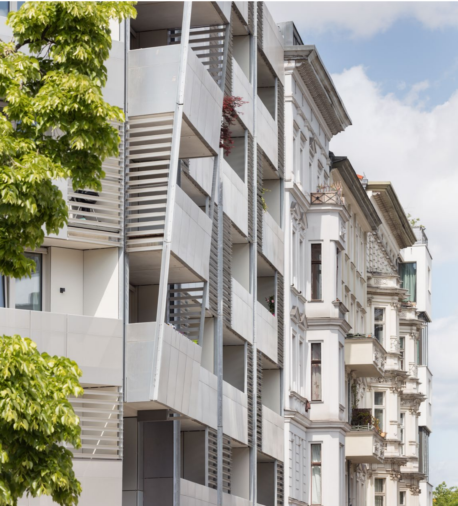
Das METROPOLENHAUS vermittelt mit unterschiedlichen Maßstäben zwischen Platz, Park und umliegenden Bestandsbauten.
