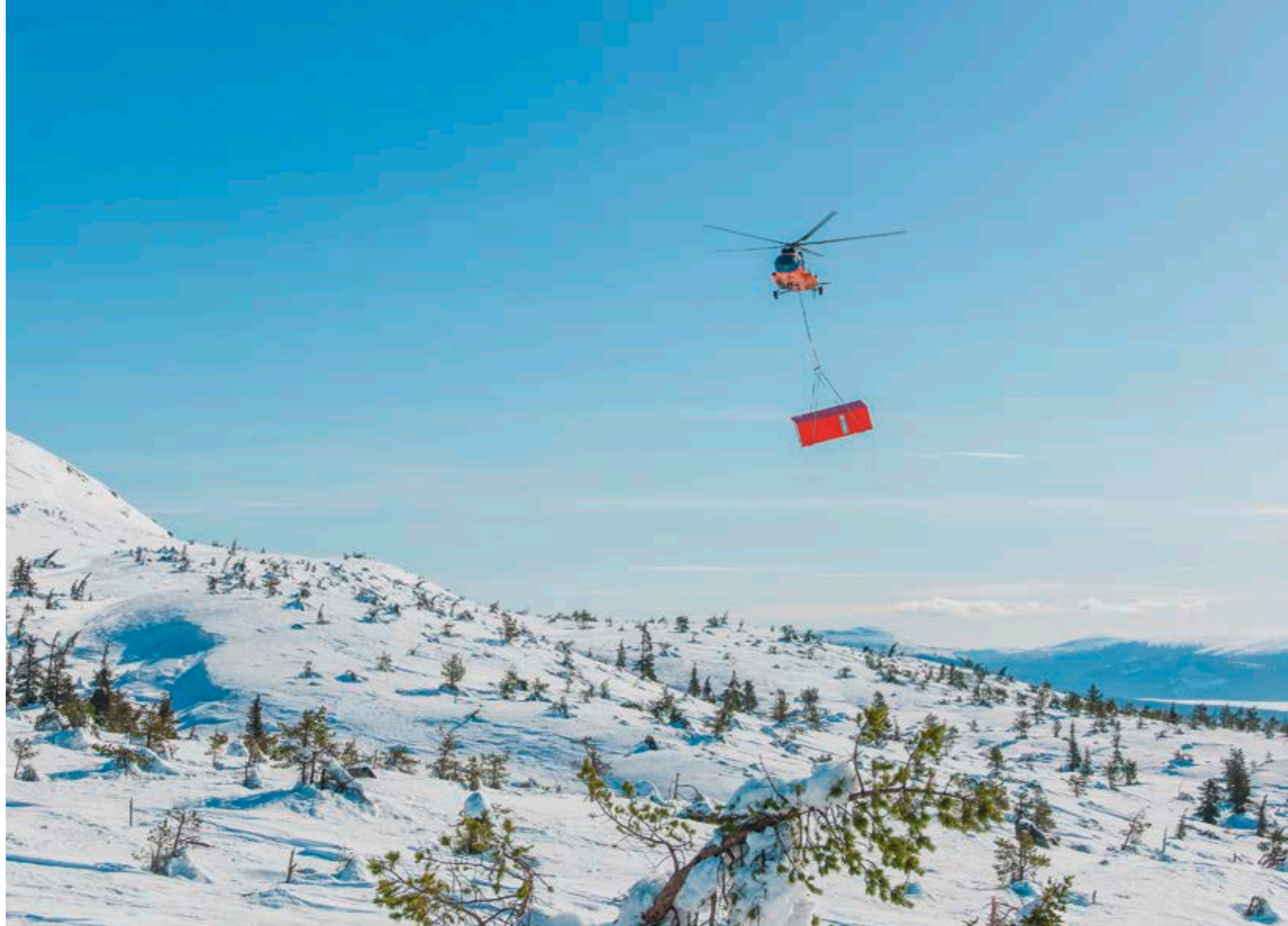
Keine Straßen, dafür Eis und Schnee, wohin man sieht. Das Gelände auf dem Berg Volosyanaya ist abgelegen und unwegsam. Die Installation war nur per Helikopter möglich.
