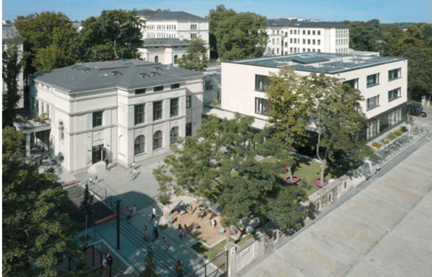
Der Schul-Neubau wurde als kompaktes Volumen auf dem städtebaulichen Abdruck der ehemaligen anglikanischen Kirche platziert. Das um eine Etage aufgestockte ehemalige Gemeindehaus der Lutherkirche beherbergt die Horträume.
