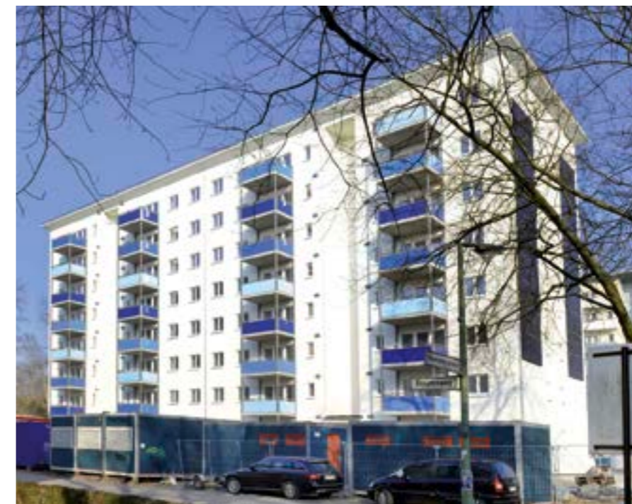
Im Rahmen der Sanierung wurden die vorhandenen Balkone abgesägt und entfernt. Die neuen Balkone wurden vor die Fassade gesetzt, damit sie thermisch vom Gebäude getrennt sind.
