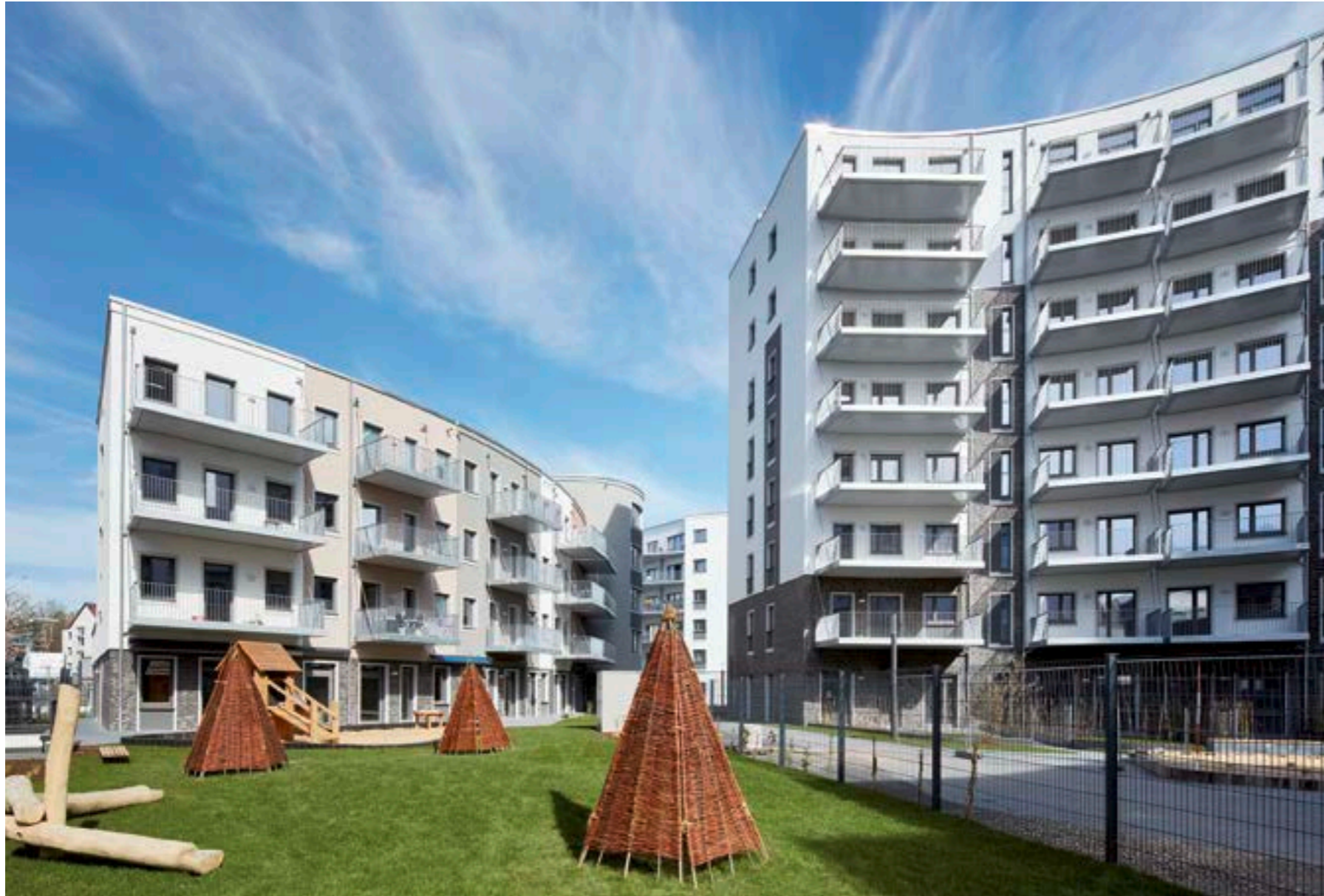
Das Quartier bietet mit Wohnungen, einer Kita mit Außenbereich und Nahversorgung einen attraktiven Mix in dem immer noch von Gewerbe bestimmten Gebiet von Düsseldorf.
