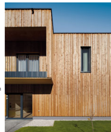
Die Fassade besteht aus Lärchenholz.
