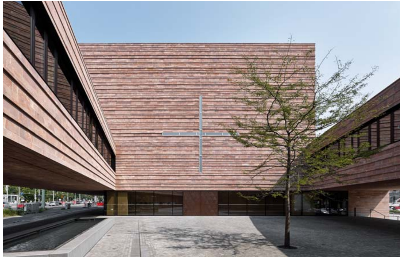
Zwischen Kirchturm und Kirchenraum ist der Pfarrhof eingeschnitten und öffnet den Baukörper zur umgebenden Stadt.
