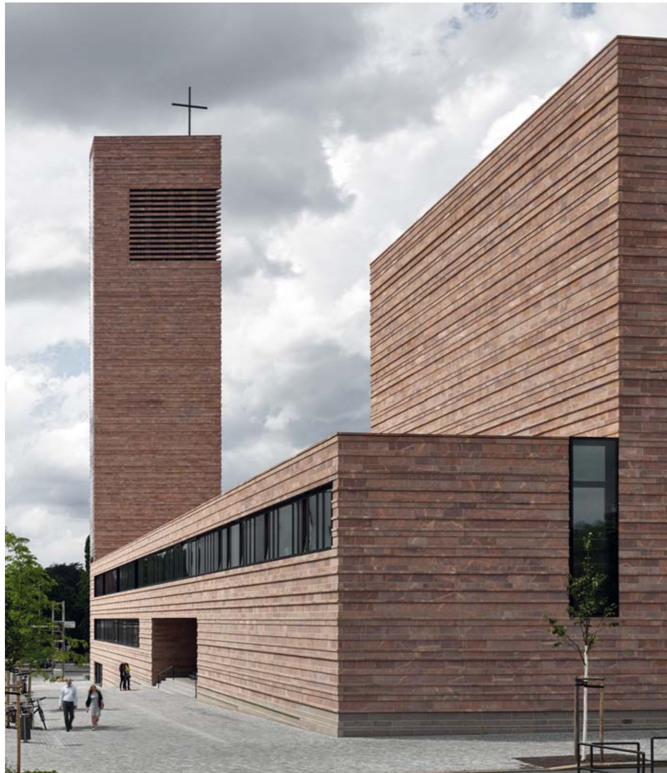
Die horizontale Schichtung des Rochlitzer Porphyrs mit Vor- und Rücksprüngen in der Fassade lässt die Kirche förmlich aus dem Boden herauswachsen.
