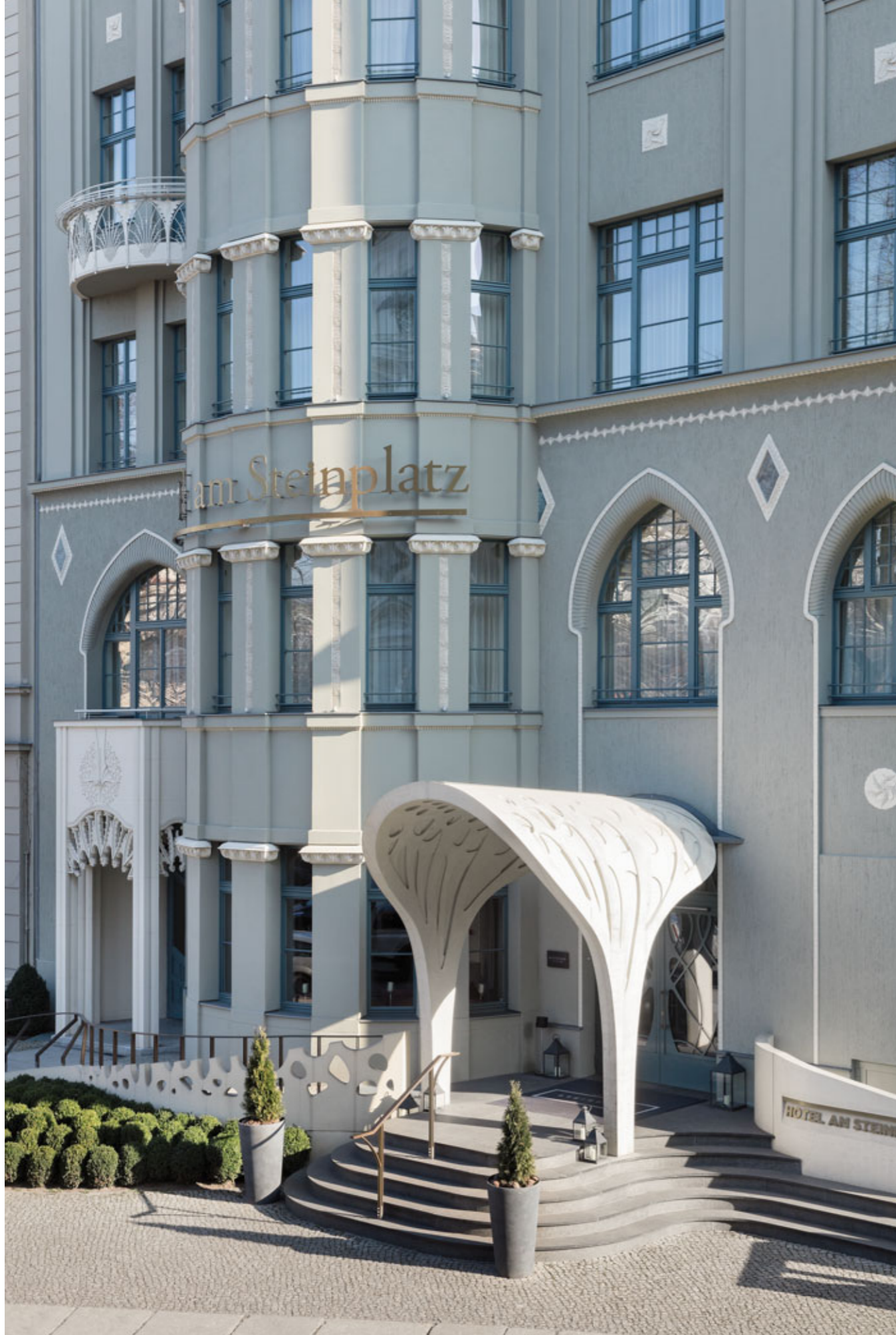
Die historischen Fassadenfarben wurden analysiert und ein Farbkonzept für die Rekonstruktion im Zusammenspiel mit den Neubau-Elementen entwickelt.
